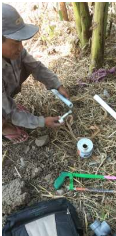
Gambar 15. Pemasangan Aksesoris Pipa
