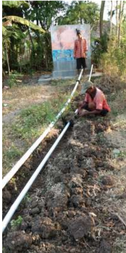
Gambar 14. PIPANISASI yang Diawali dari Bak Penampungan Air BPBD
