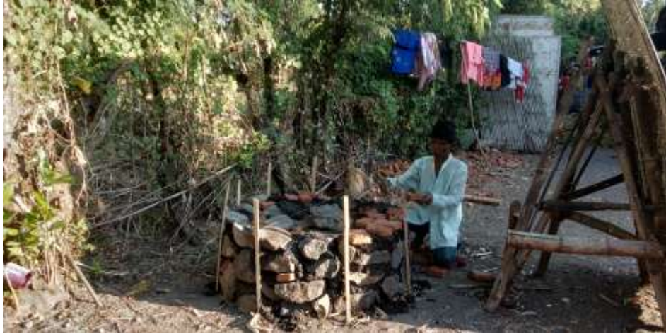
Gambar 12. Pembuatan Bangunan Pondasi Tandon
