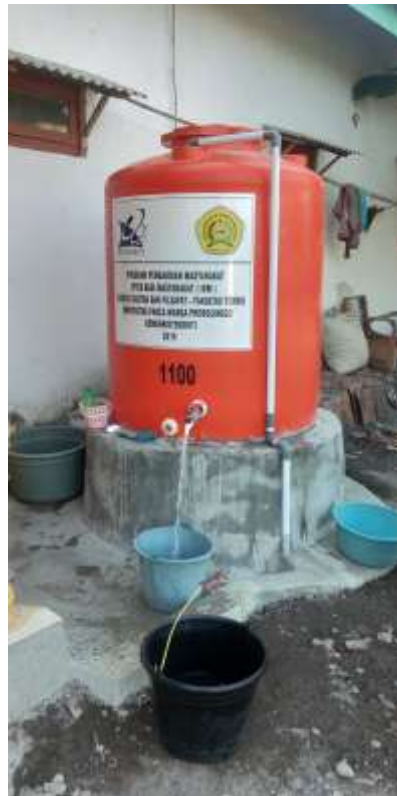
Gambar 9. Model Tandon Air dan Podasi yang Dipasang di Lokasi
