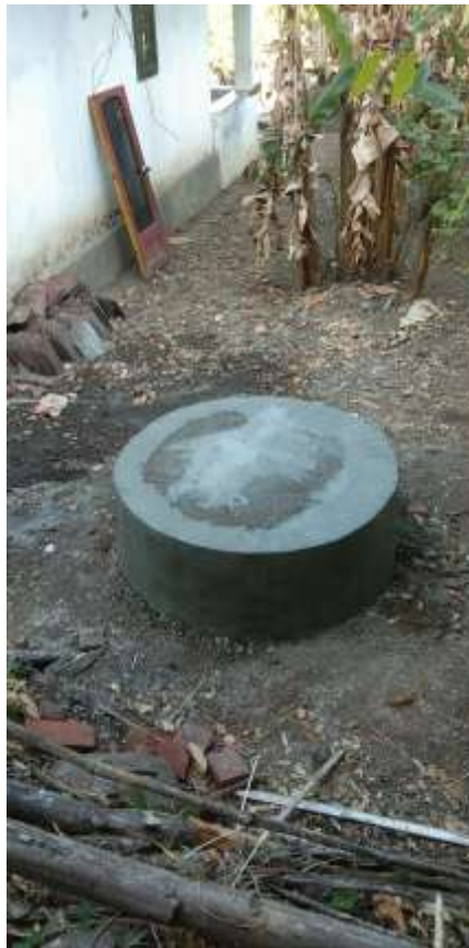
Gambar 13. Bangunan Pondasi Tandon
