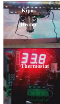
Gambar 14 Implementasi sistem di ruang pengering
