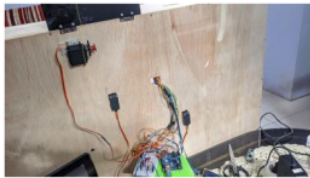
Gambar 2. Pemasangan seluruh komponen
