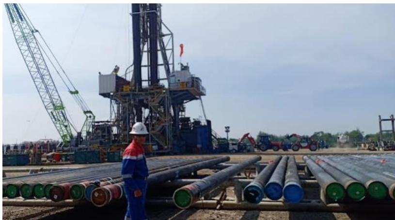
Gambar 1.5. Contoh pipa casing yang harus dipasang pada pengeboran gas seperti pada proyek Lapindo Brantas [Oil Creative]
