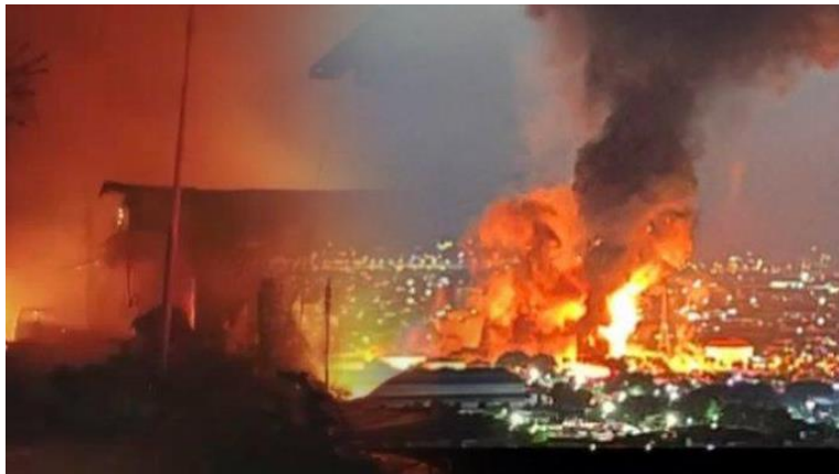
Gambar 1.8. Kebakaran melanda Depo Pertamina di Plumpang, Koja, Jakarta Utara, pada Jumat (3/3/2023). Kebakaran terjadi tepat di pipa penerimaan BBM di Integrated Terminal BBM Jakarta, Plumpang [Foto satelit, dari TribunSolo.com]
