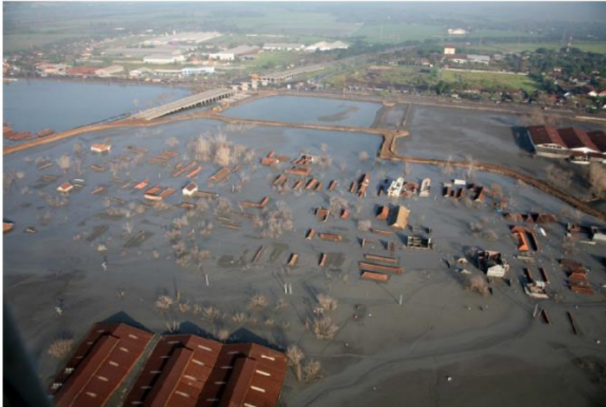
Foto udara Desa Siring dan Renokenongo yang terkubur banjir lumpur Lapindo [Geoffrey S – USGS, 2008 ]
