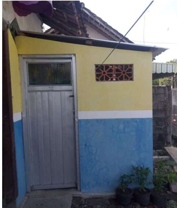
Gambar 4.12 Hasil Akhir Pembangunan Jamban (Tampak Depan)
