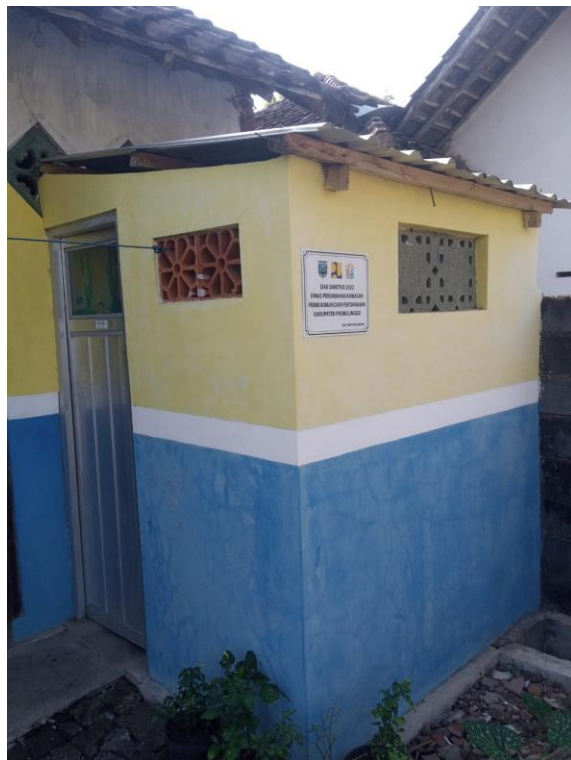
Gambar 4.13 Hasil Akhir Pembangunan Jamban (Tampak Samping)
