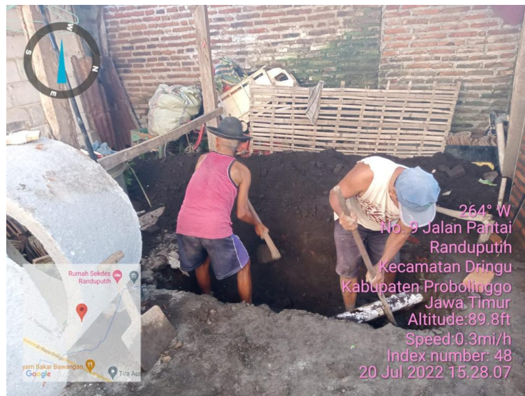
Gambar 4.9 Proses penggalian tanah untuk pembuatan tangki septic
