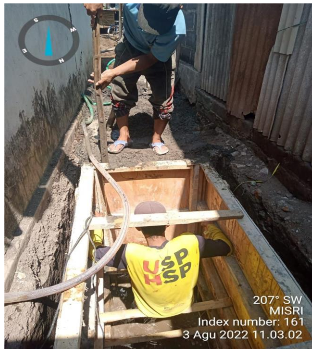
Gambar 4.10 Proses pembangunan tangki septik
