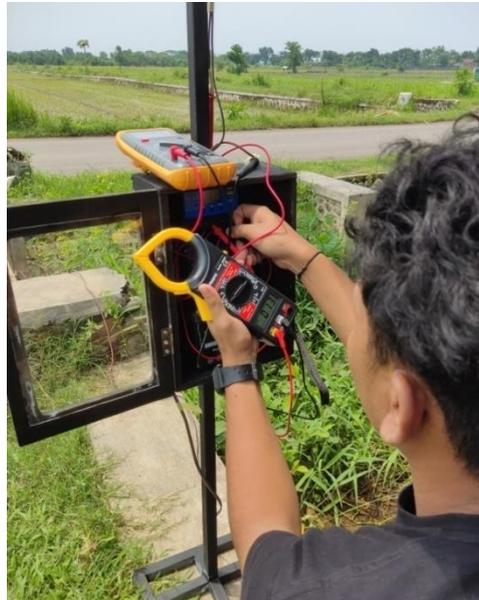
Gambar 4.18 Pengukuran Vin Charge Control di Sungai Brumbungan Lor
