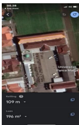
Gambar 4.4 Gedung Bahasa Universitas Panca Marga (Sumber : Google earth satelit )
